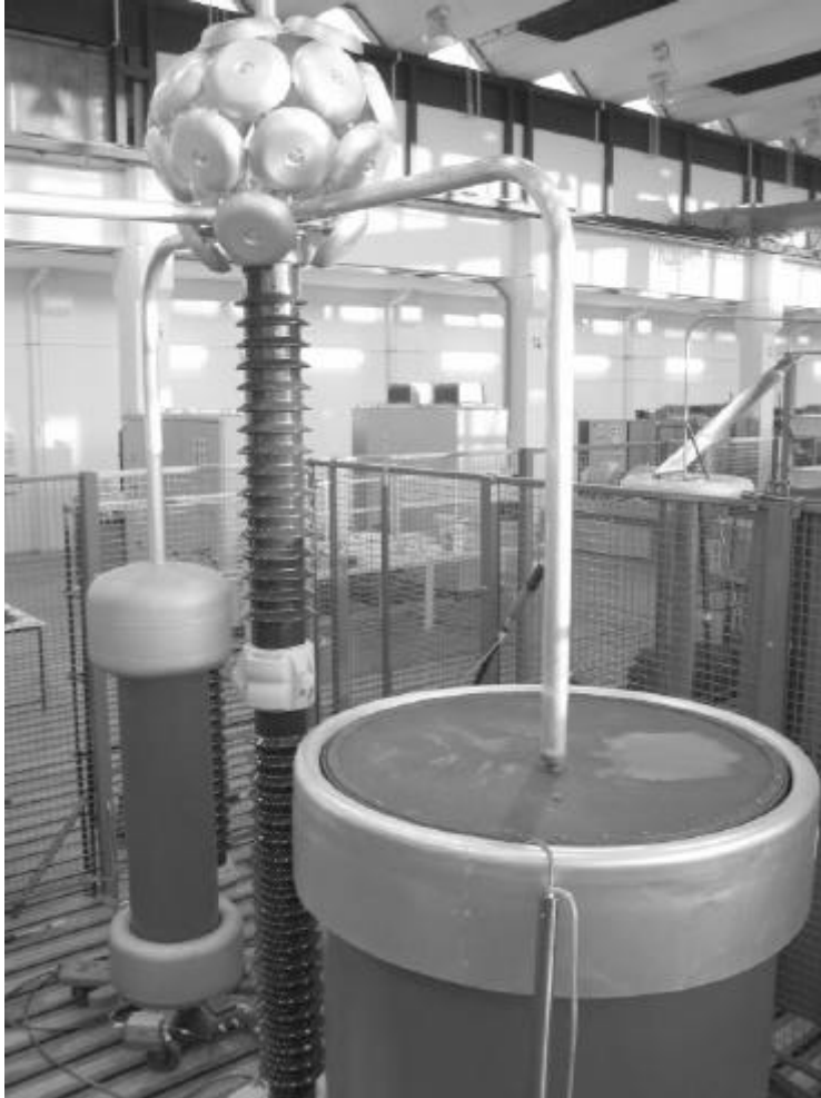
Abbildung: Wechselfspannungs-Prüfsystem zur Erzeugung von Wechselfspannungen bis 200kV
